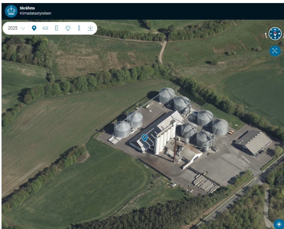
Skråfoto fra forår 2025 set fra syd - Der er efterfølgende opført 2 store siloer yderligere sydvest for de eksisterende siloer. Bygningen der ændrer anvendelse er markeret med blå prik på taget. Udkørselsanlægget placeres mellem bygningen, der ændrer anvendelse og de høje hvide siloer.
